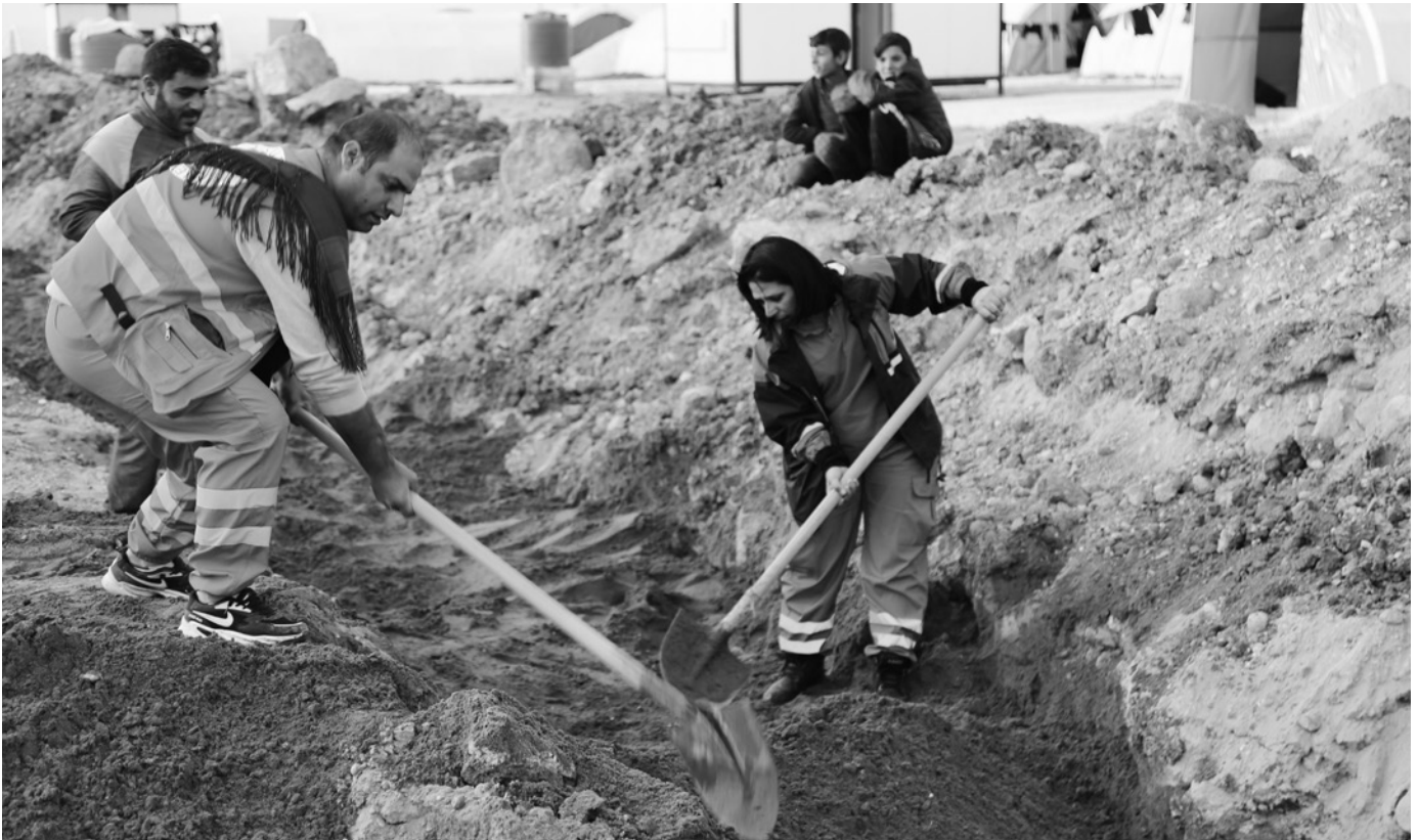
Der kurdische Rote Halbmond bei der Einrichtung von Kanalisationsgräben in einem Lager in Nord- und Ostsyrien | Foto: Heyva Sor a Kurd
